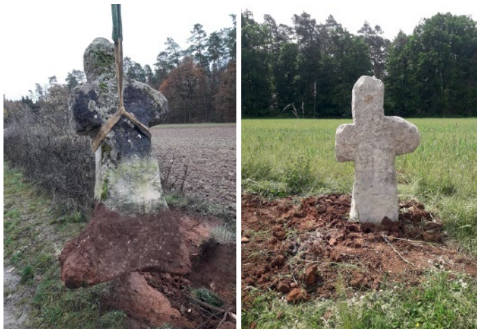
Foto: Das Schwedenkreuz vor und nach der Sanierung.
